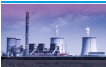
Generación de energía
