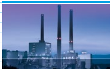
Construcción de instalaciones
