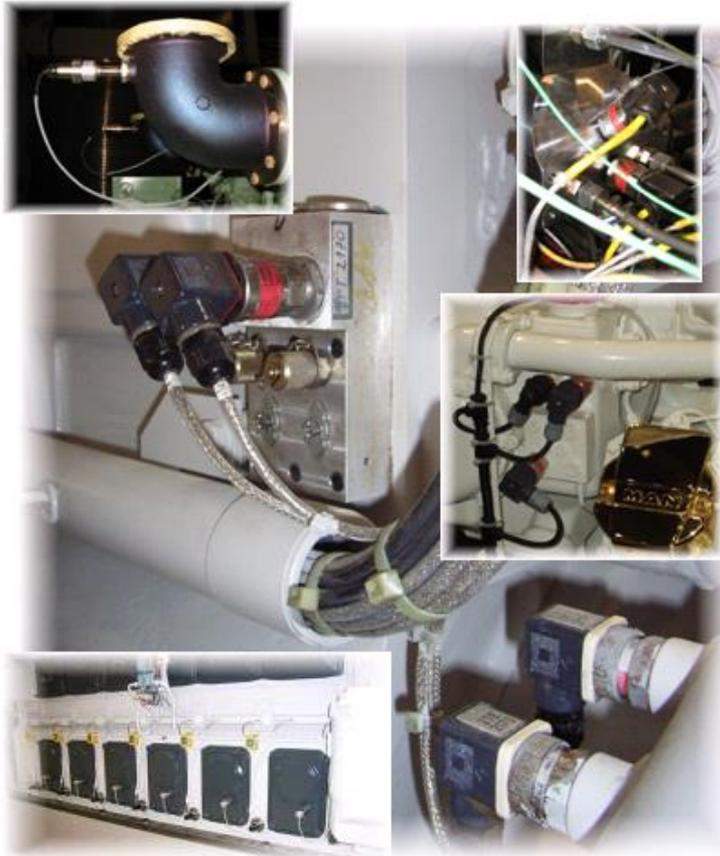
Control de presión de aceite lubricante, control y alarma
